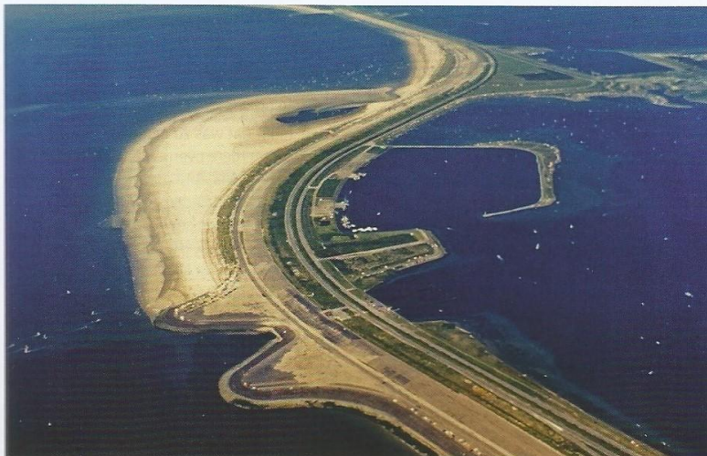
In 1978 is de Brouwerssluis (onder) in gebruik genomen. De sluis in de Brouwersdam verbindt het Grevelingenmeer met de Noordzee en is ook bruikbaar voor verzoeting van het meer. (Foto: Beeldbank Rijkswaterstaat)
