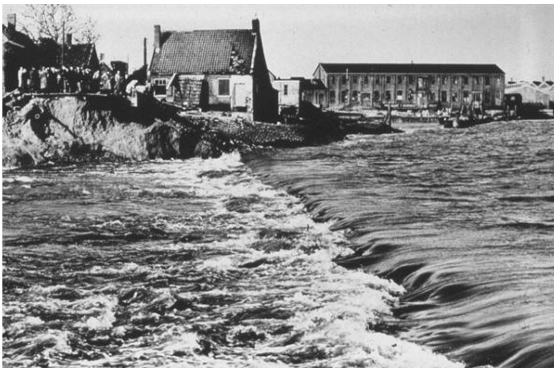
Figuur 8: Een dijkdoorbraak in 1953. De vorm van de instortingswand onder de toeschouwers duidt op dijkval. Het water stroomt over een drempel het gat in dat de verweekte en weggeleden dijk achterliet.
